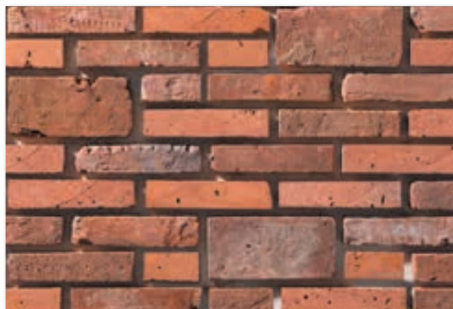
Red レッド 大判フラット (内・外面ミックスと併用した施工例)
