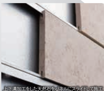
上下溝加工をした天然石をパネルにスライドして施工
